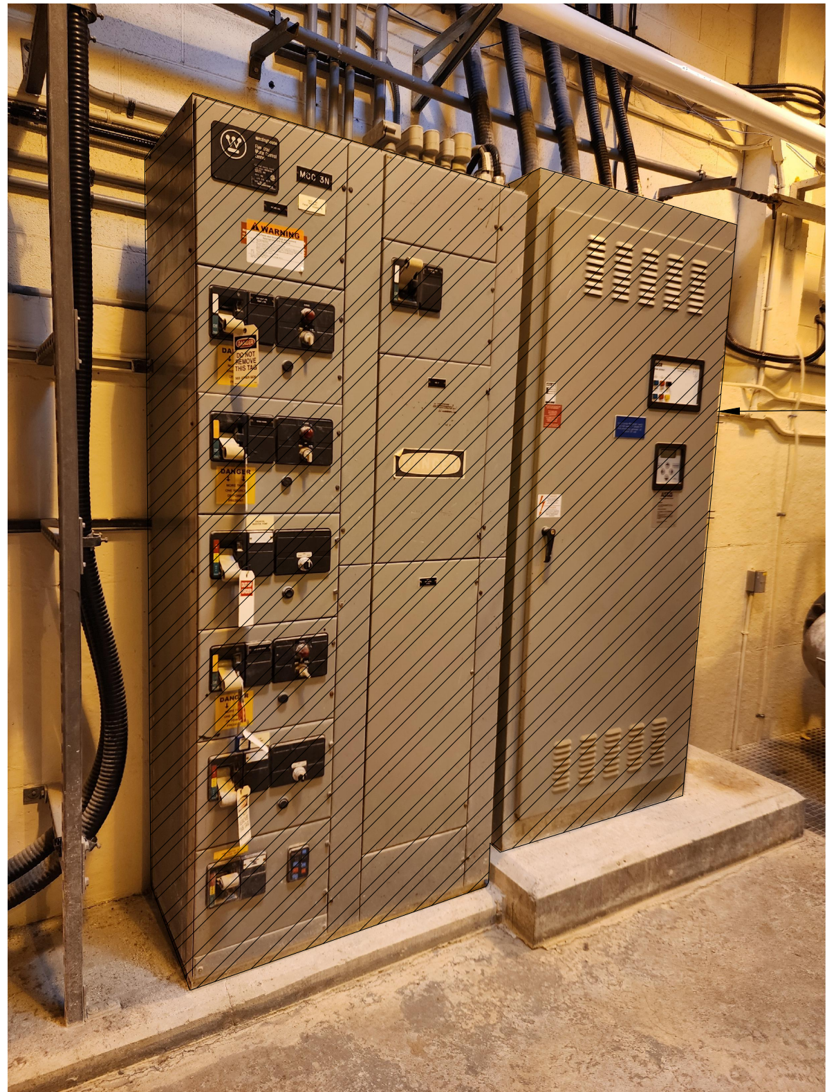
P3 EXISTING MCC-3N AND ATS E101 SCALE: N.T.S.
