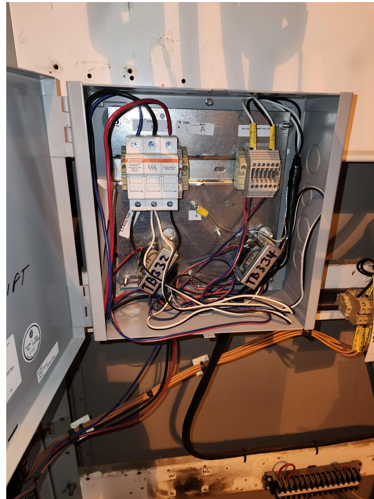
P5 EXISTING PTs BOX DETAIL IN HLP-5 E408 SCALE: N.T.S.
